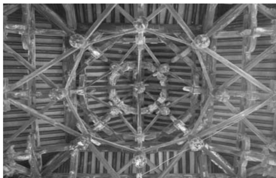
圖9：沁水縣嘉峰鎮郭壁村崔府君廟明代舞樓藻井
